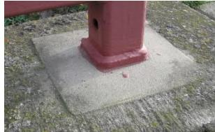
**cds-V-Mörtel flex standfest** ist ein pigmentierter, flexibilisierter, mit definierter Sieblinie gefüllter, 2-Komponenten-Epoxidharzmörtel und wird vorwiegend für die Verfüllung von Aussparungen beim Geländerpfosteneinbau verwendet. Er erfüllt die Anforderungen analog den BASt-Richtzeichnungen Gel 12, 13, 14.
