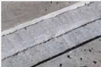
Durch Ausfräsen wird die notwendige Geometrie hergestellt
