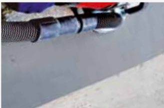
Abschließend werden die Ränder der Fugenmasse höhengleich zu den angrenzenden Flächen verschliffen
