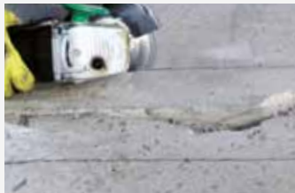
Rechts und links der Fuge wird der abzutragende Bereich durch Einschneiden mit dem Winkelschleifer begrenzt
